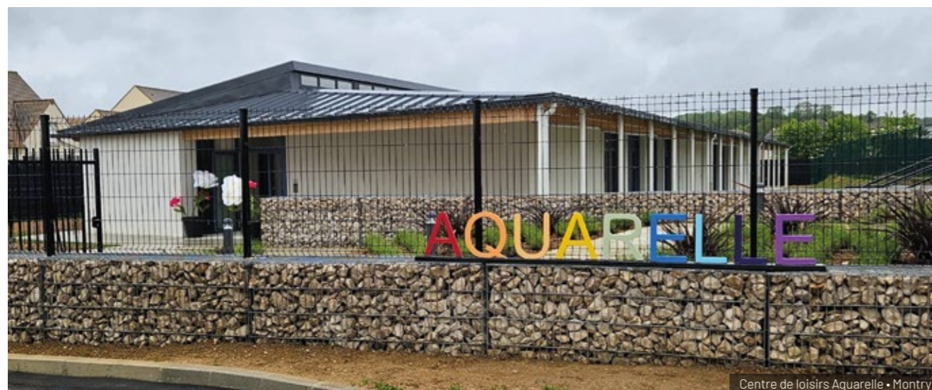
Centre de loisirs Aquarelle • Montry
